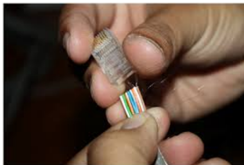
Gambar 3.15 Proses Memasukan Kabel ke Konektor
