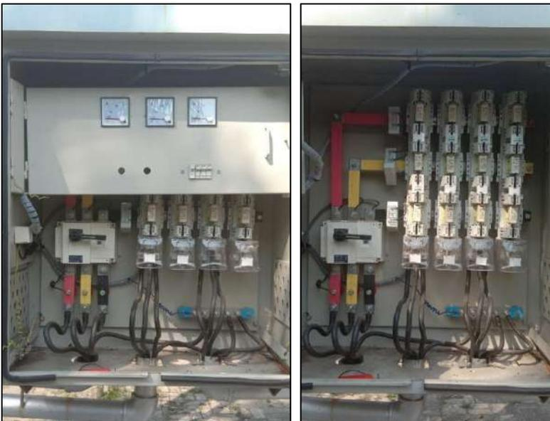
Gambar 4.1 Panel Hubung Bagi Tegangan Rendah (PHB-TR)
