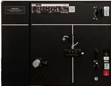
5. Mengoperasikan kubikel untuk *de-energize* (memutuskan tegangan) pada sisi pelanggan
