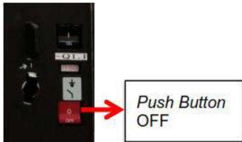
6. Mengoperasikan kubikel untuk *de-energize* (memutuskan tegangan) pada sisi PLN.
