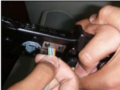
Gambar 98. Pemotongan Serat Kabel dengan *Crimper*
