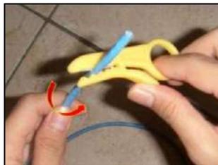
Gambar 93. Pengupasan Kabel dengan *Stripper*
