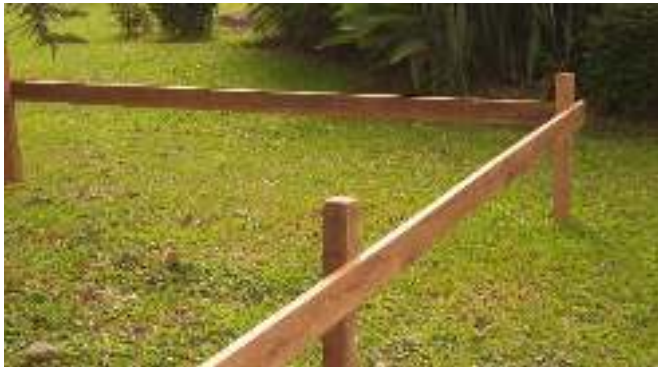
Gambar 1.8 Uitset Bouwplank Terpasang
