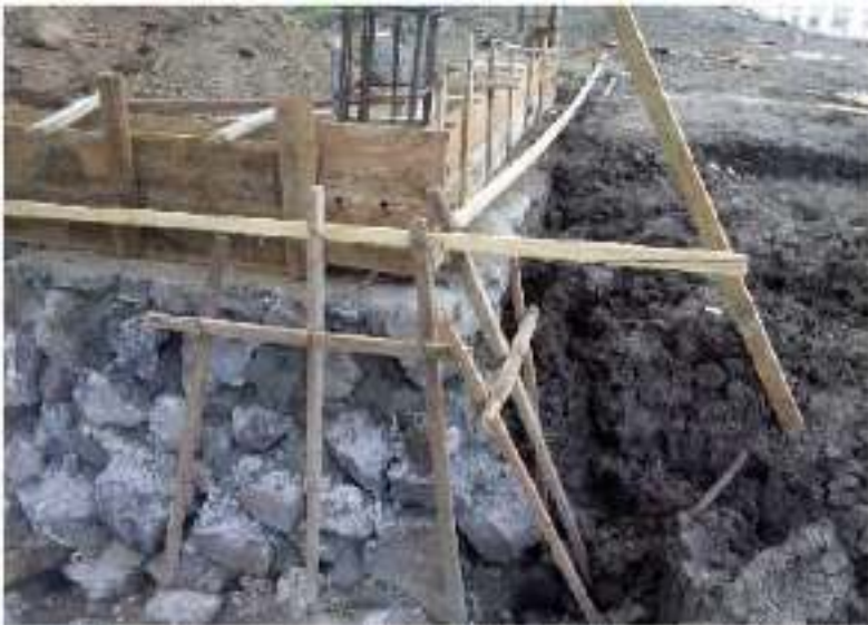
Gambar 2.1 Foto Pondasi Batu Kali
