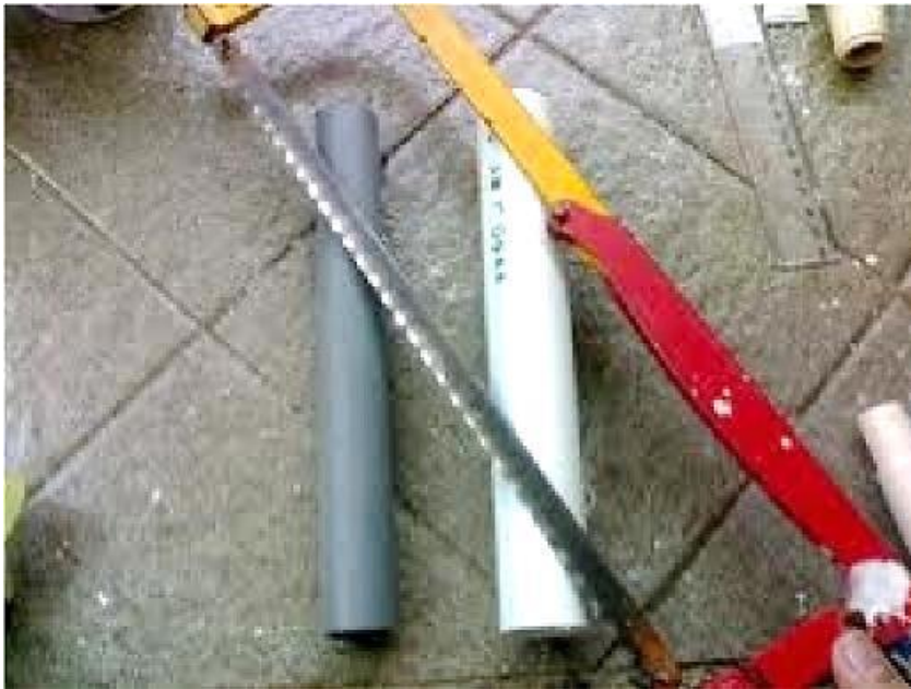
Gambar 2. 5 Memotong pipa menggunakan gergaji besi
