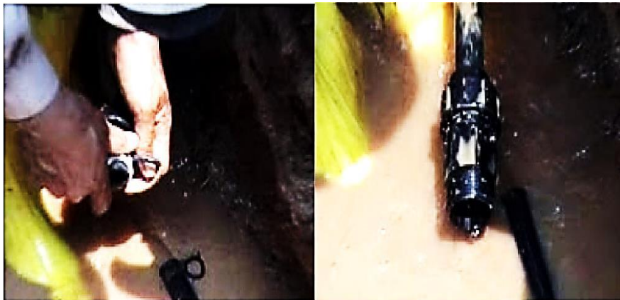
Gambar 2.12 Membuka semua sambungan fitting
