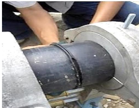
Gambar 2.17 Setelah dingin alat hydraulic dilepas
