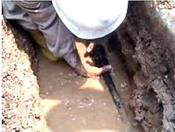
Gambar 2.13 Mempertemukan sambungan fitting dengan mengulir
