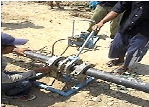
Gambar 2.15 Meleleh menggunakan heating plate
