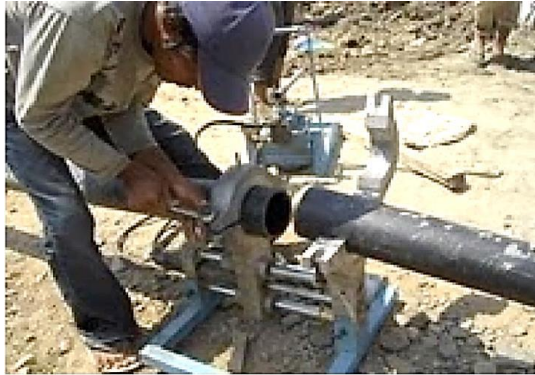
Gambar 2.14 Penyambungan electrofusion
