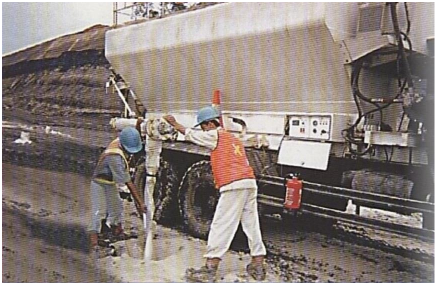
Gambar 3.6 Mengisi lubang ledak di tambang terbuka
